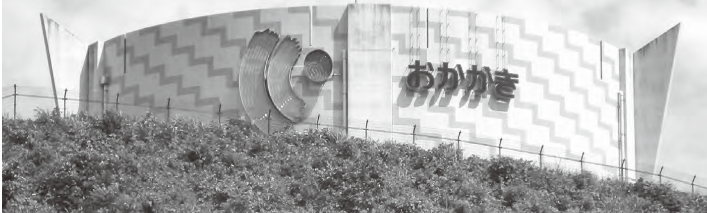
▲岡垣バイパスから見える海老津配水池
